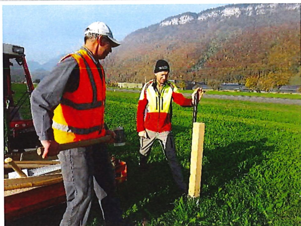
Setzen von Zeigerpfählen im Feld
