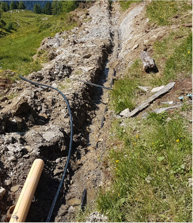
Salaz, pose de la nouvelle conduite d’eau
