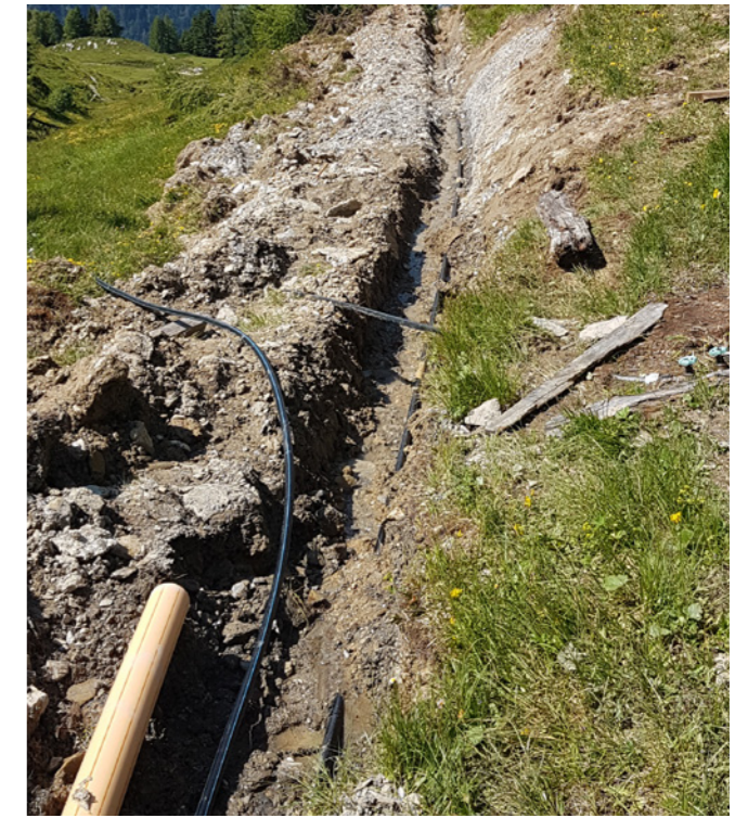
Einzug der neuen Wasserleitung Alp Salaz Foto: Gemeinde Untervaz
