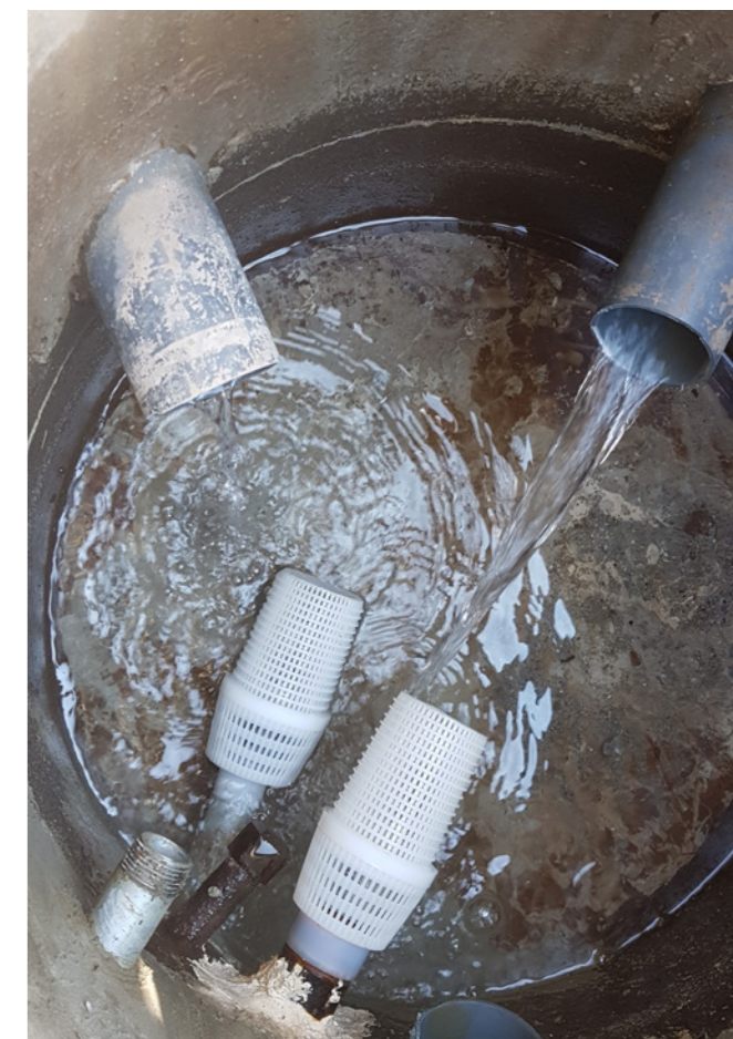
Sanierung Wasserversorgung Alp Salaz Foto: Gemeinde Untervaz
