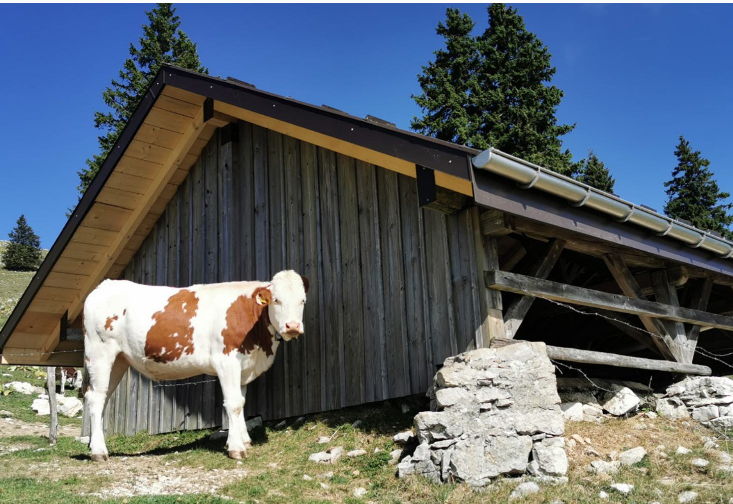
Neukonstruktion zur Sammlung des Dachwassers für die Zisterne
