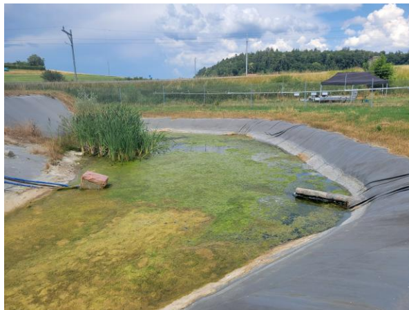
Abbildung 7: Hilfsteich für die Sammlung des Drainagewassers. Von hier wird das Wasser ins Hauptbecken gepumpt.
